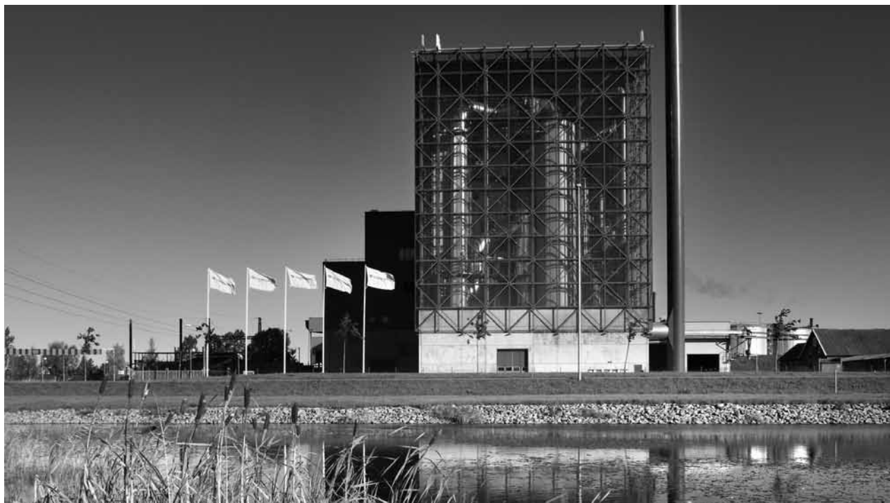
Ежегодно в «Йерстадсверкене» сжигают 330 тысяч тонн сортированного мусора, из которого получают топливо для производства электроэнергии, тепла и биогаза
